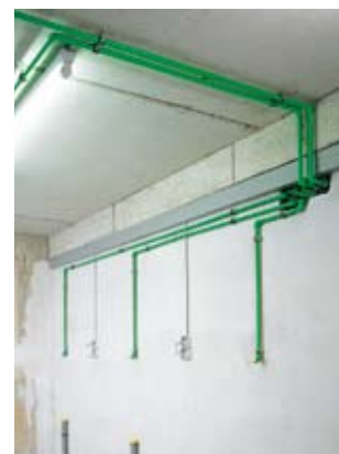
монтаж на штукатурку
