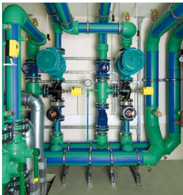
монтаж распределителя из комбинированных труб фузиотерм® Фазер и большого шарового крана
