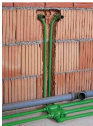
монтаж под штукатурку
