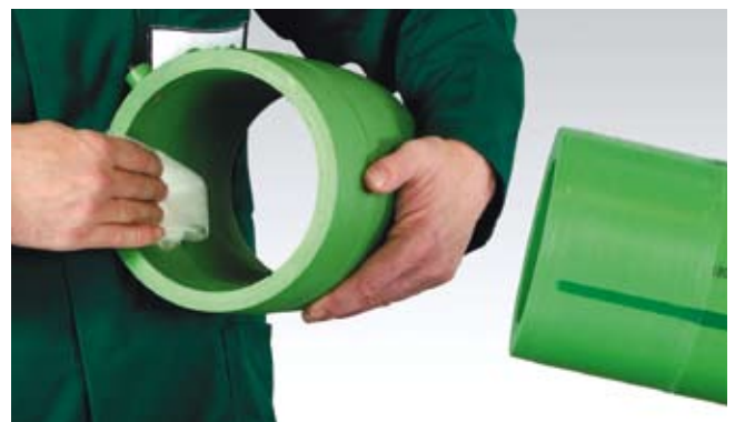
чистка внутренней поверхности электромуфты
