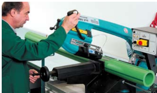
перед сваркой отрезать трубу на желаемую длину
