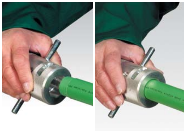
зачистка алюминиево-полипропиленового слоя (только для труб Штаби)
