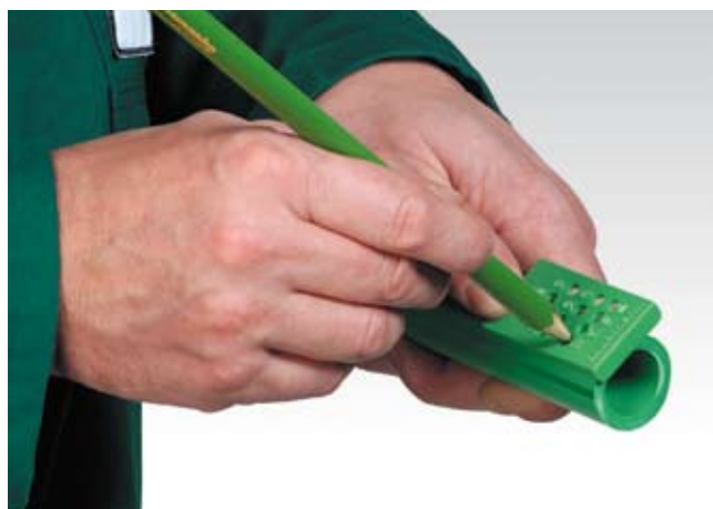
отметка глубины сварки
